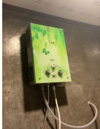
ภาพภาคผนวก ข-2 การติดตั้งเครื่องทำน้ำอุ่นระบบแก๊ส
