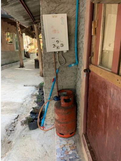
ภาพภาคผนวก ข-2 การติดตั้งเครื่องทำน้ำอุ่นระบบแก๊ส
