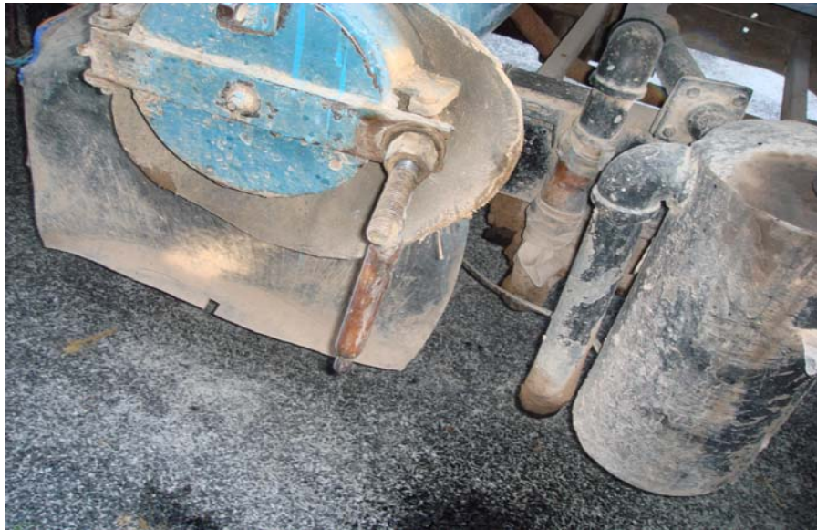
ร่อนน้ำส่งปลูกมีการรั่วซึมลงสู่พื้นถนนที่ร่วน
